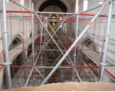
Das Gerüst wird nun im Langhaus und im Querschiff aufgebaut. Diese Arbeiten werden ca. 4 Wochen dauern. Danach werden auch hier die Decken- und Wandflächen, wie im Chor, gereinigt.
